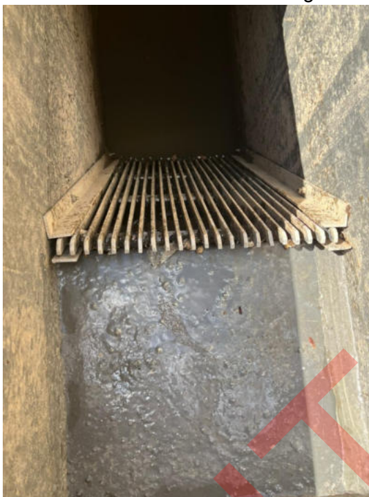
Figura 40: Gradeamento do Sistema de Esgoto da Sanepar.
