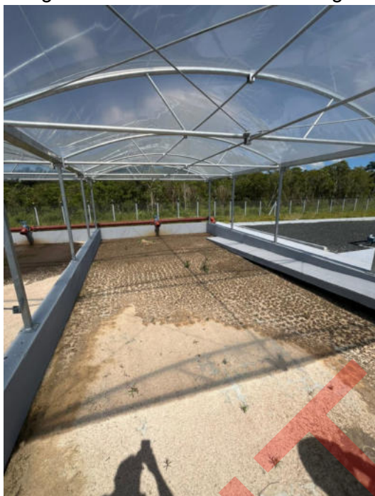
Figura 42: Secagem de Lodo do Sistema de Esgoto da Sanepar.
