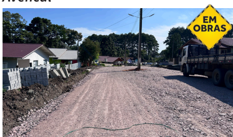
Rua Santo Antônio, Ponte Alta
