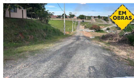
Rua Rio Preto, Centro
