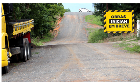
Rua Amazonas, Centro
