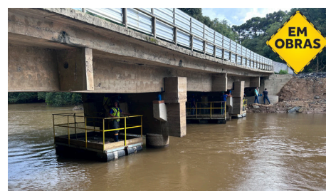
Revitalização da Ponte no Fundão, Campina dos Maia
