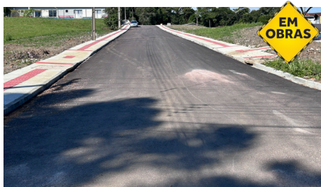
Rua Osasco, Ponte Alta
