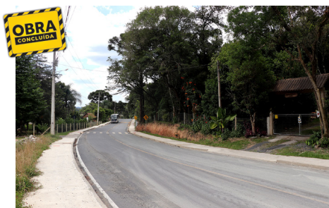
Rua Belo Horizonte
