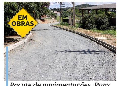
Pacote de pavimentações. Ruas Belo Horizonte, Diadema, João Pessoa, São Cristóvão, Tocantins. Total 1,3km. Investimentos de R$ 1.951.000,00.
