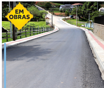
Trecho 03 da Campina dos Maia. Pavimentação de 1,5km. Investimentos de R$ 2.462.000,00.
