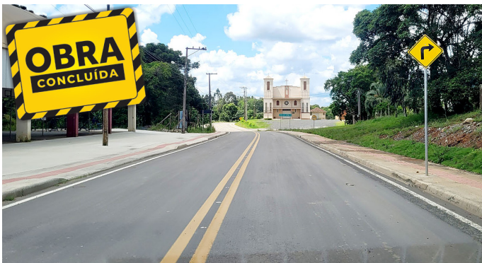
Est. Principal, Campina dos Maia. Pavimentação de 500m, investimentos de R$ 573.890,37
