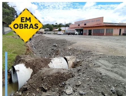
Trecho 02 da ligação Ponte Alta/Campina dos Crespins. Pavimentação de 2km. Investimentos de R$ 2.772.000,00.
