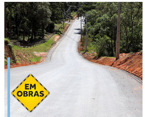
Estrada sentido Centro/Poço Frio. Pavimentação de 2,2km. Investimentos de R$ 2.753.493,31.
