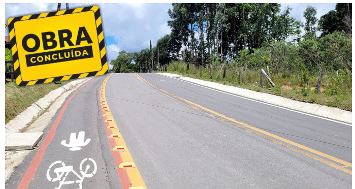
Subida do Trevo. Pavimentação de 373m, investimentos de R$ 408.922,05
