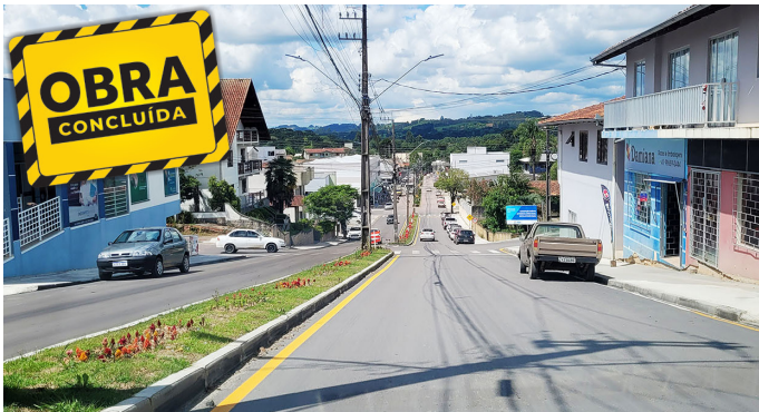
Avenida Brasil, no Centro. Pavimentação de 138,82m, investimentos de R$ 384.930,28
