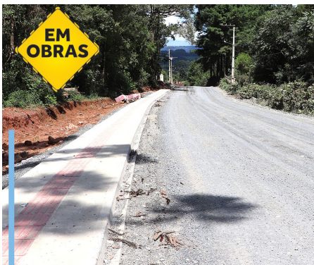
Trecho 01 da Campina dos Maia. Pavimentação de 1km. Investimentos de R$ 2.180.000,00.
