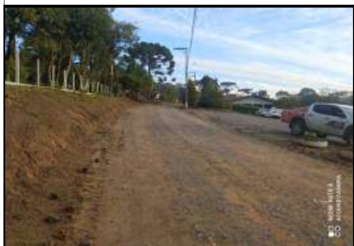
Estrada Municipal K0-002 Trecho 02 (Estaca 122+0,00 sentido estaca 123 )
