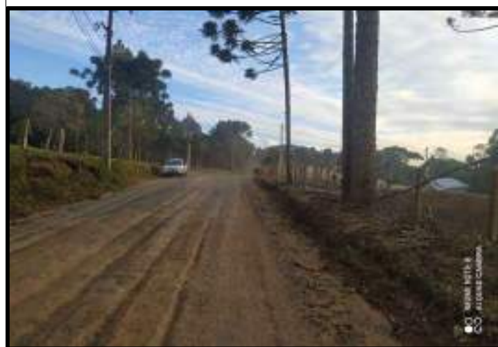
Estrada Municipal K0-002 Trecho 02 (Estaca 132+0,00 sentido estaca 133 )
