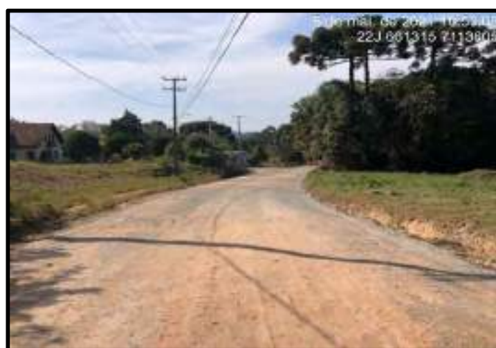
Estrada Municipal K0-002 Trecho 02 (Estaca 76+0,00 sentido estaca 75 )
