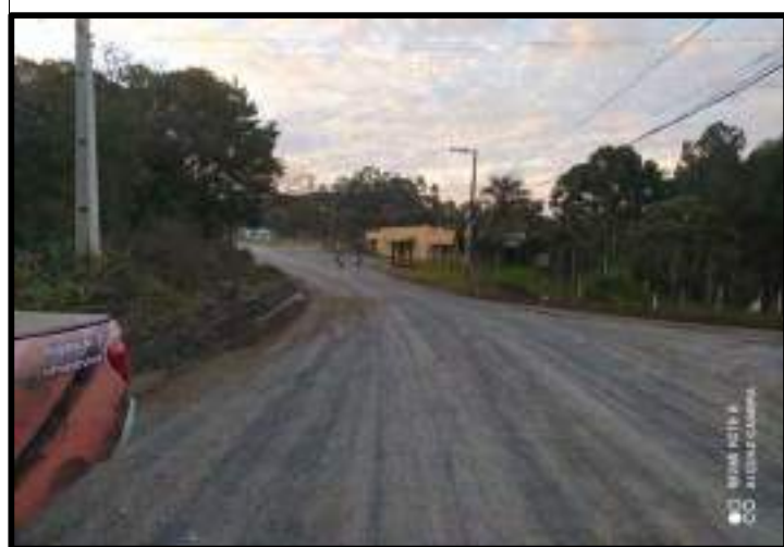
Estrada Municipal K0-002 Trecho 02 (Estaca 62+0,00 sentido estaca 63 )
