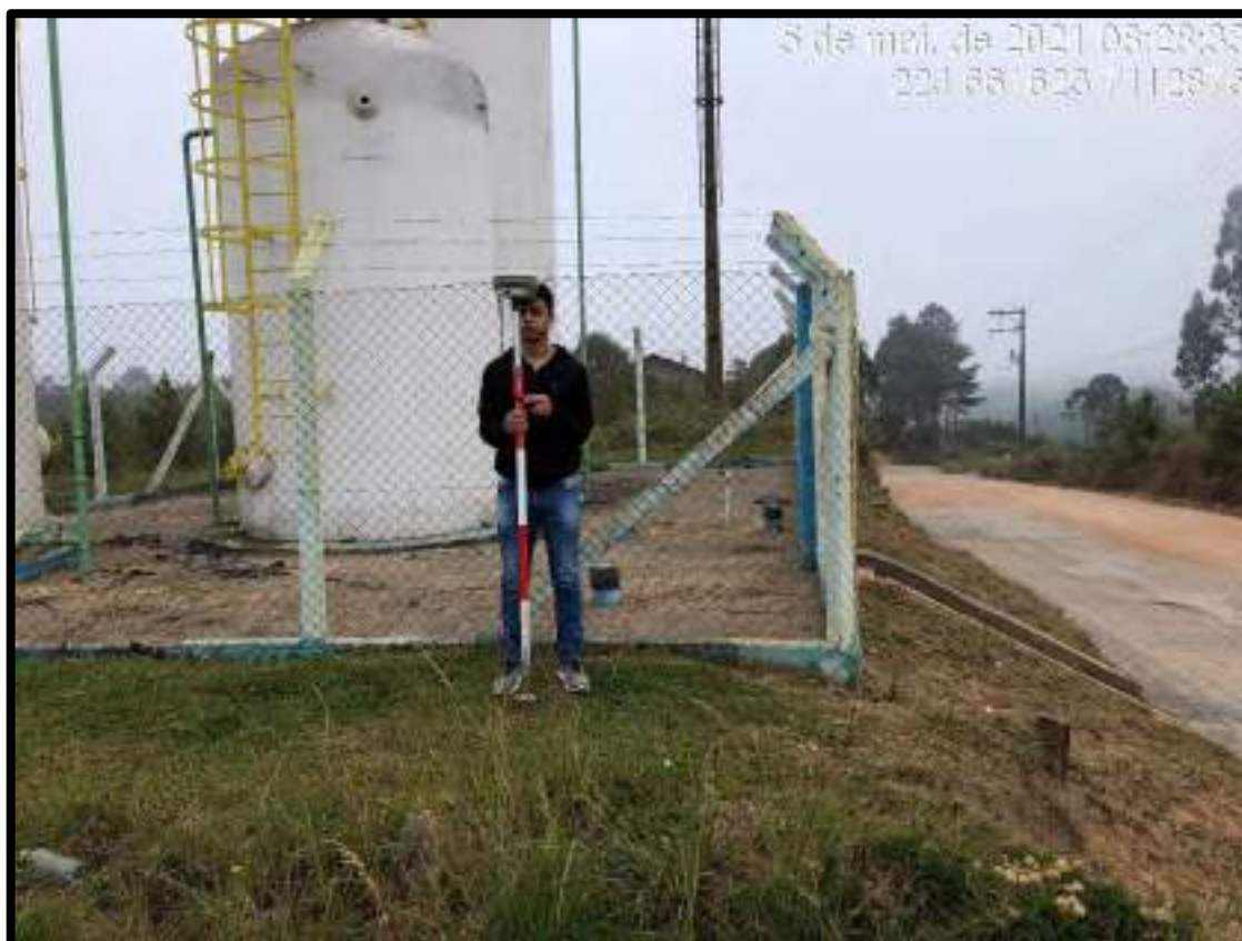
Marco implantada próximo a caixa de água
