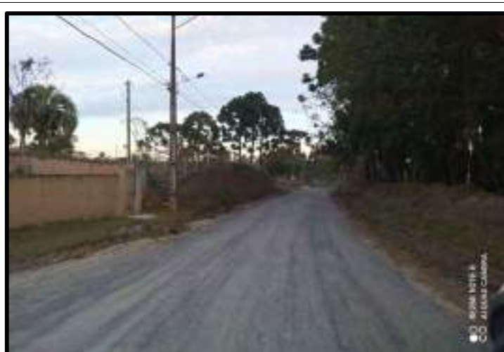
Estrada Municipal K0-002 Trecho 02 (Estaca 60+0,00 sentido estaca 61 )
