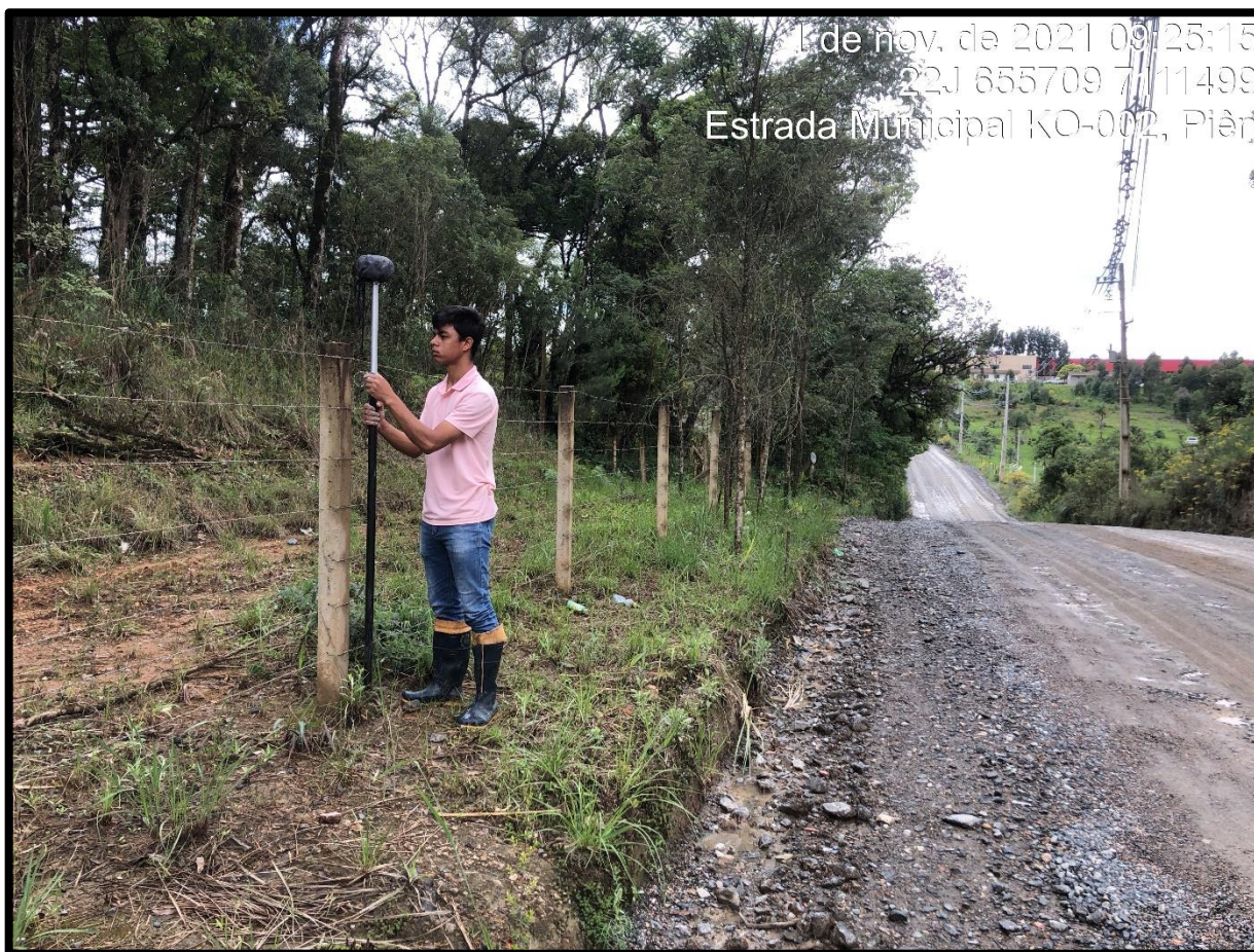
Marco implantada próximo a cerca, em projeto estaca 21+11,20 Lado Direito
