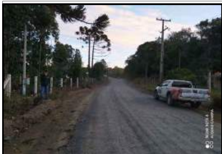
Estrada Municipal K0-002 Trecho 02 (Estaca 56+10,00 sentido estaca 57 )
