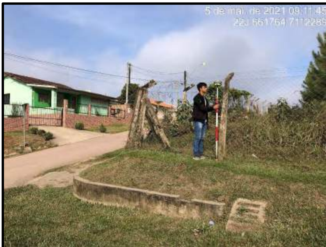
Marco implantada a esquina da Rua Olávo Bilac
