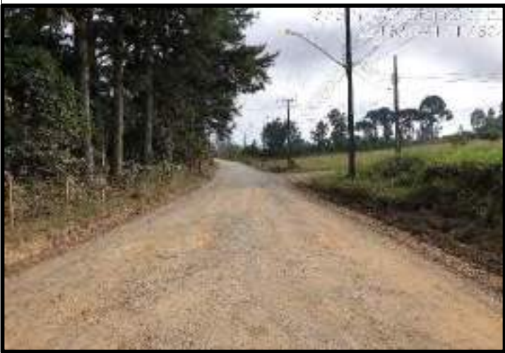
Estrada Municipal K0-002 Trecho 01 (Estaca 10+11,00 sentido estaca 12 )
