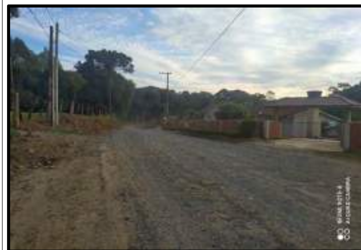
Estrada Municipal K0-002 Trecho 02 (Estaca 137+0,00 sentido estaca 138 )
