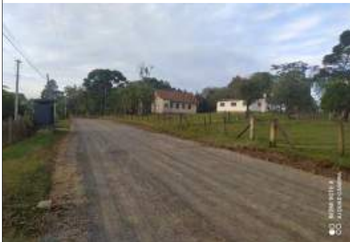
Estrada Municipal K0-002 Trecho 02 (Estaca 131+0,00 sentido estaca 130 )
