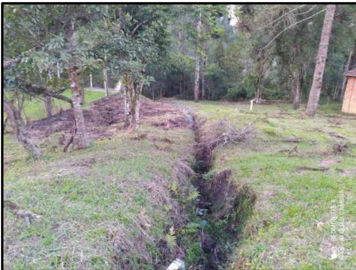
Desague em vala existente.
